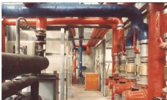
**CASERTA - PALAZZO REALE** - Giardini Inglesi - serra per produzione di piante tropicali a pompa di calore elioassistita con ausilio di energia geotermica
